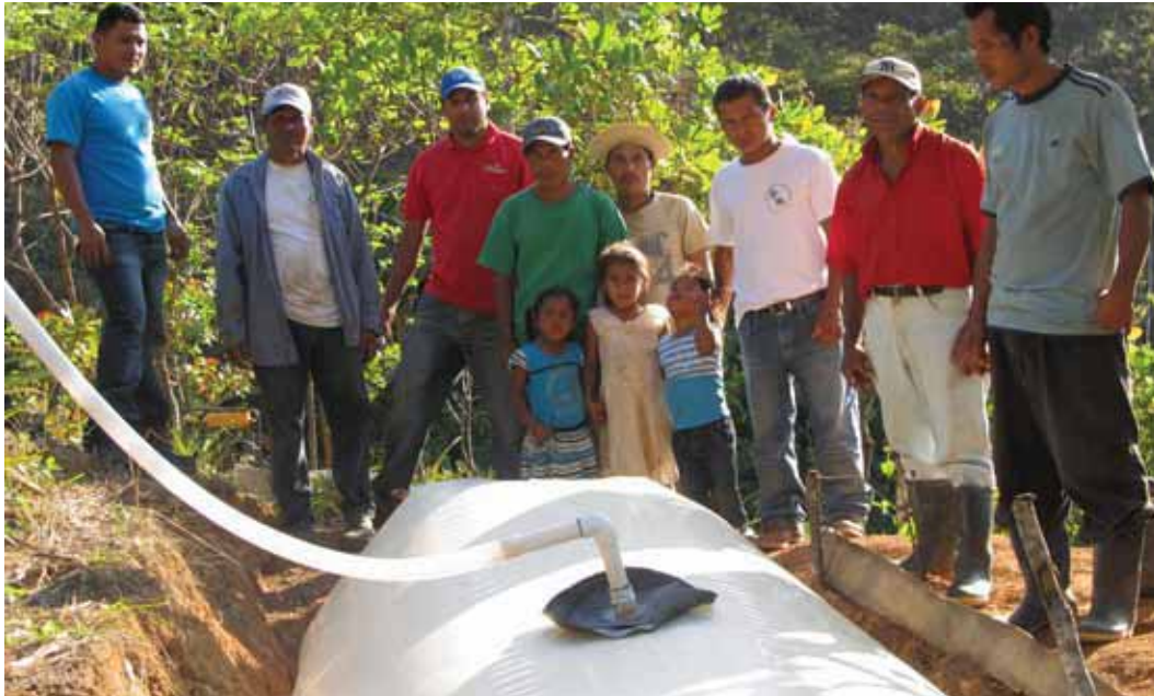
Biodigestor en un 70% de su construcción.
