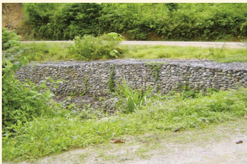
Figura 1. La construcción de gaviones en zonas vulnerables en uno de los logros de la MAMUCA
