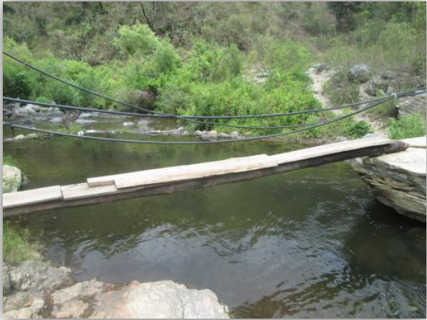
Figura 30. Sistema de mangueras para distribución de agua en la comunidad de Toluca
