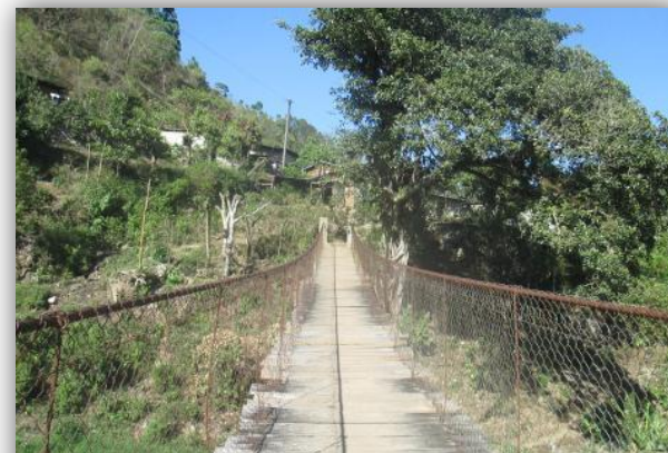
Figura 28. Puente colgante sobre el río La Suiza en Toluca
