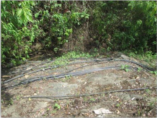
Figura 30. Sistema de mangueras para distribución de agua en la comunidad de Toluca
