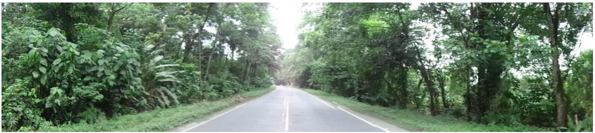
Figura 45 Fotografía panorámica de Punto Semi-caliente de Mamíferos Terrestres N°1.
