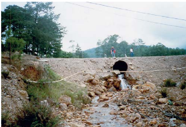
La Quebrada Agua Amarilla tiene una alta velocidad de socavación, un caudal pico considerable y drena por donde hay mayor concentración de población, lo que causa graves daños a la infraestructura.
