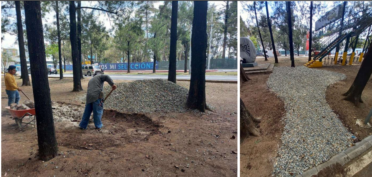
Se realizó un trazado y posterior excavación manual a 30 cm de profundidad y relleno con pedrín. Se colocó el letrero educativo "Soy un jardín de lluvia"
