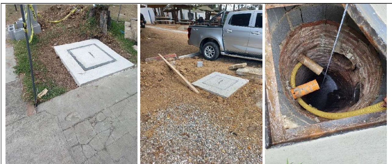
Pozos con tapaderas mejoradas (pozo_MIX-02 y pozo_MIX-03)
