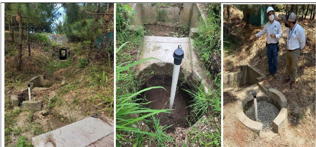
Secuencia de estructuras de pretratamiento en diferentes momentos del año (caja sedimentadora y pozo con relleno de piedrín y grava)
