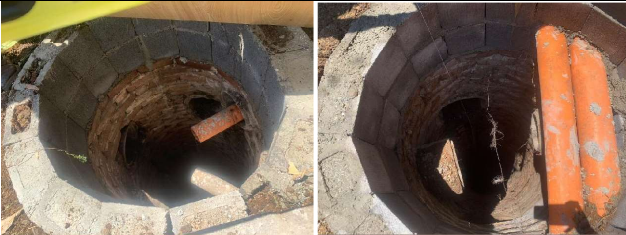
Mejora en zona de brocales y medición de profundidad
