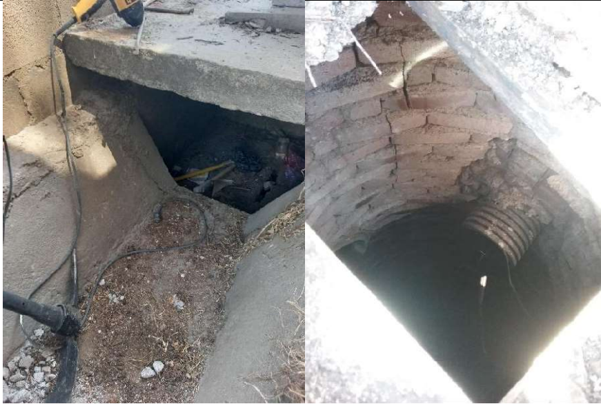
Pozos existentes en las instalaciones del hospital que fueron mejorados en su brocal y tapaderas.
