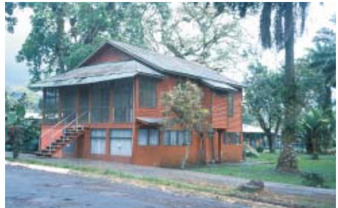
Figura 3. Uno de los edificios de La Hulera, aún presente en el campus de la Sede del Atlántico de la Universidad de Costa Rica, en Turrialba.
