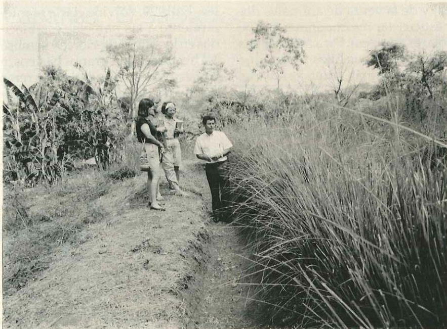
Las acequias de ladera tipo trinchera son obras de conservación que ayudan a evitar la erosión del suelo y a mantener la estabilidad del mismo. (Foto: CENTA).
