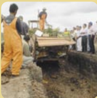
Trabajos realizados para la readecuación del vertedero a cielo abierto en un relleno sanitario en el Municipio de Jalapa.
