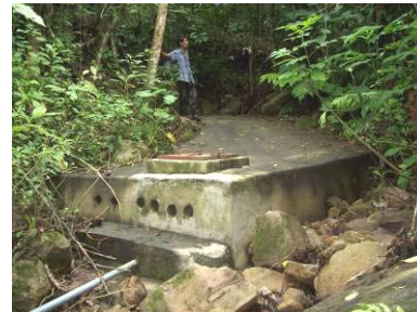
Obra de captación en Nuestra Tierra
