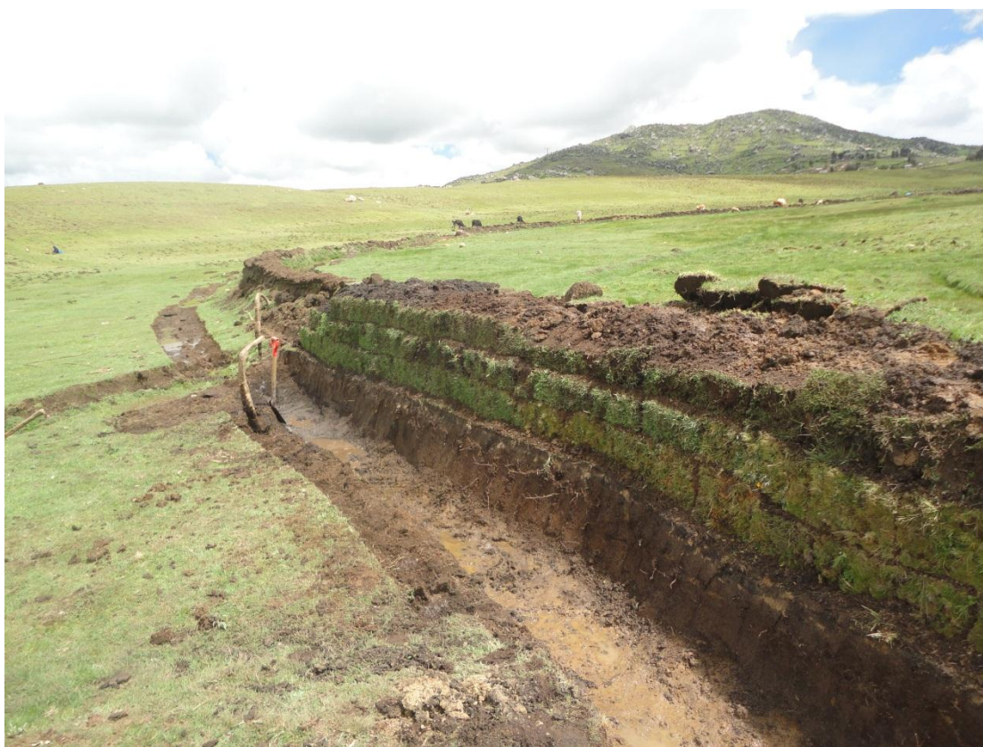
Figura 10. Clausura de praderas utilizando champas o terrones de tierra
