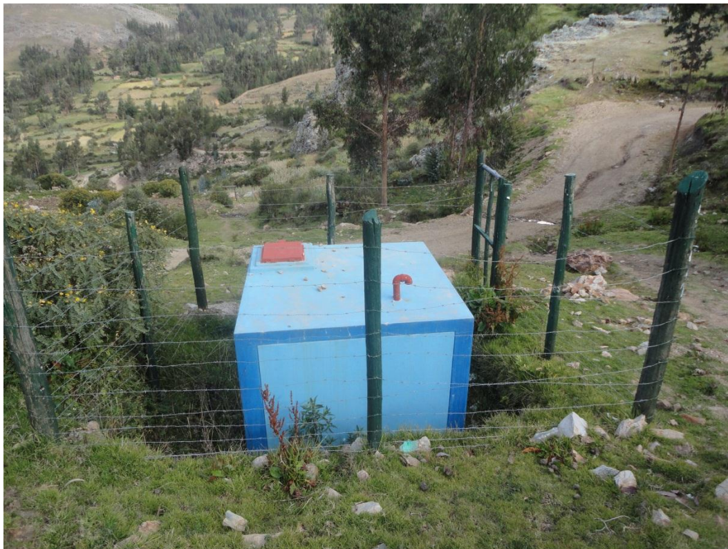
Figura 7. Reservorio de agua potable en la comunidad de Checyapa
