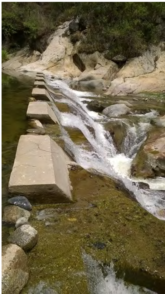
Fotografía 3 – Presa de captación del río Teculután
