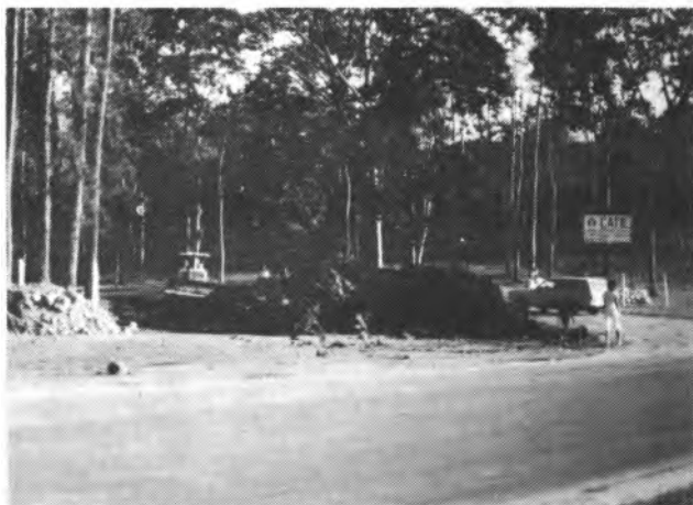
Vista parcial de los trabajos realizados en la entrada principal del Centro.
