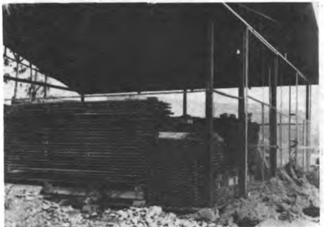
Galpón construido para el secado de la madera producida en el área del complejo agroforestal "La Molina".
