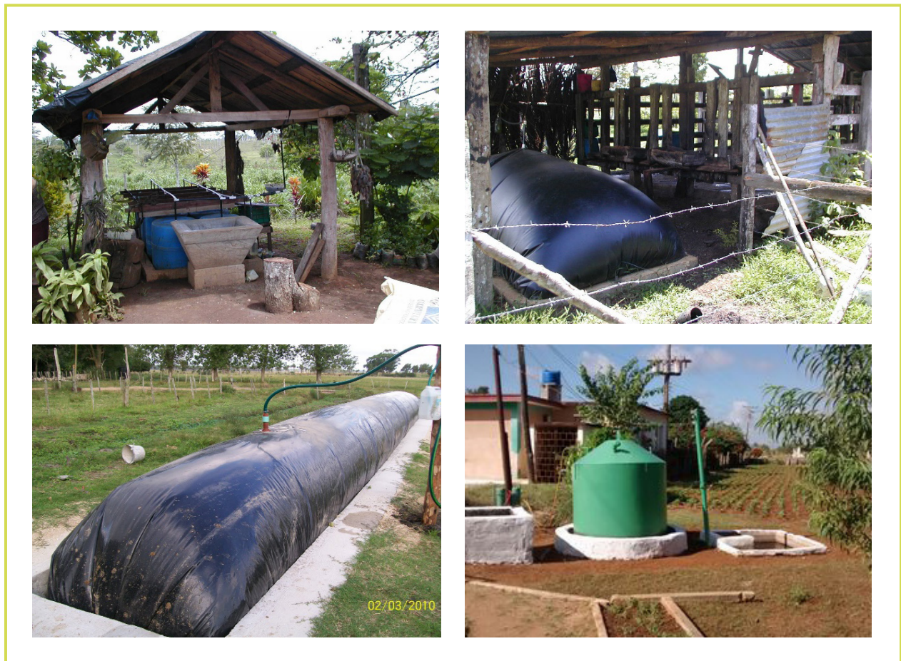
Figura 5.4. Diseños de biodigestores para uso en fincas ganaderas Fotografías: Michael López- Herrera
