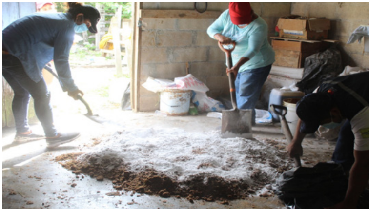
Figura 7.10. Mezcla del material cementante con el resto de ingredientes Foto: Rodolfo Avila Cab
