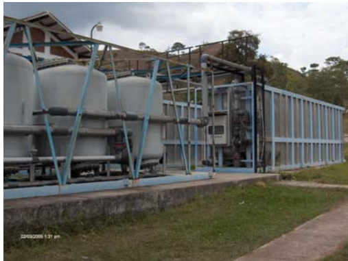
Planta Potabilizadora Copán Ruinas
