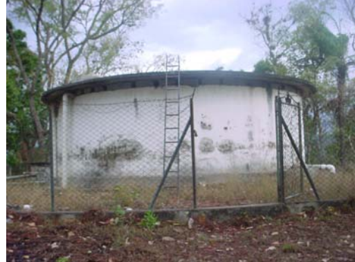
Tanque de distribución San Pedrito
