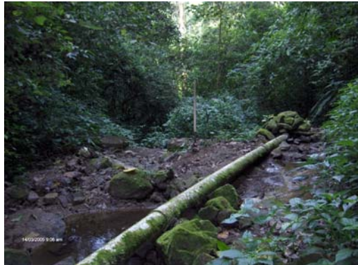
Tramo de conducción El Malcote
