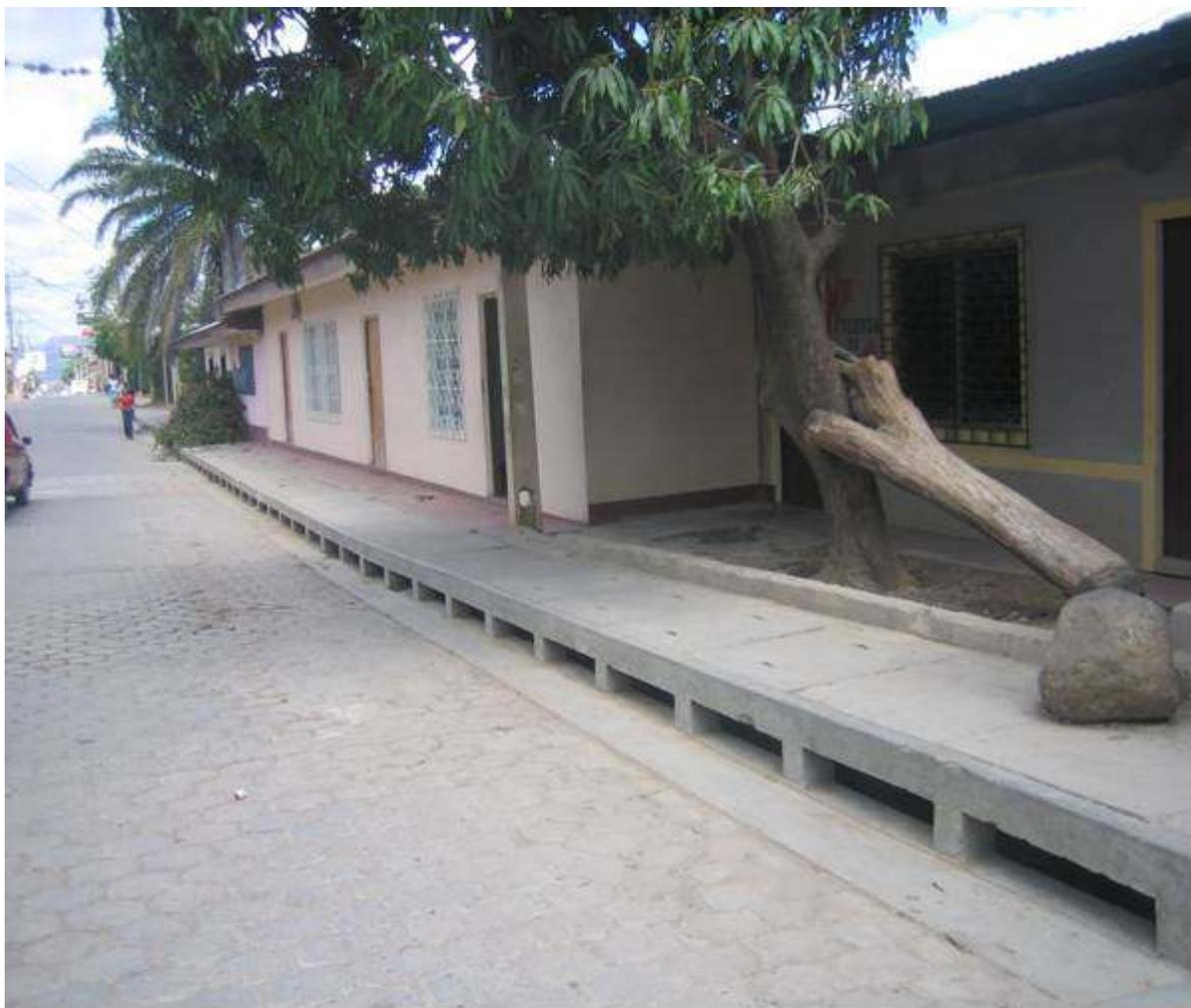
*Figura 29. Encunetado y adoquinado de calles, revestimiento de cauces subterráneos en la ciudad de Somoto (sector 5).*
