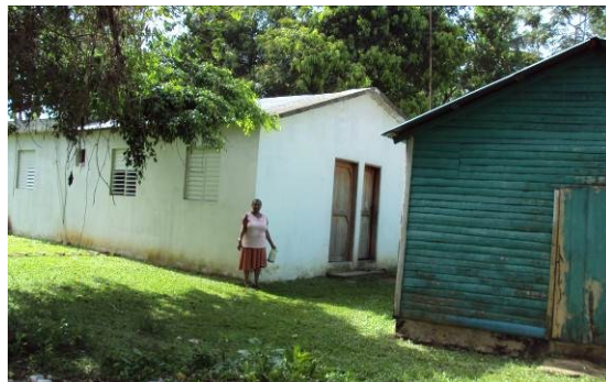
Figura 22 A partir de la producción forestal, las familias han podido construir viviendas más seguras (Foto: Carrera, F.).
