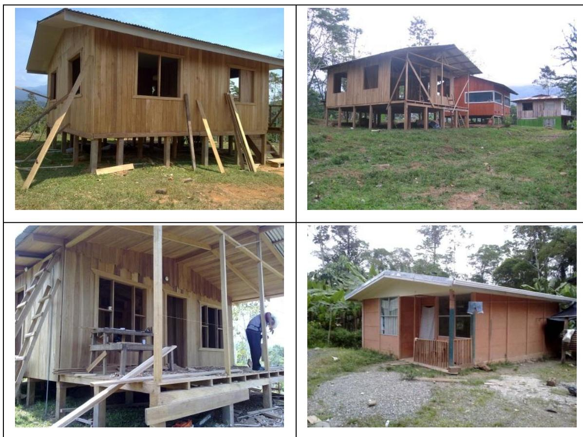
*Figura 12. Proyecto de viviendas en el Territorio Indígena Taynín. Casas nuevas prefabricadas de cemento y de madera.*
