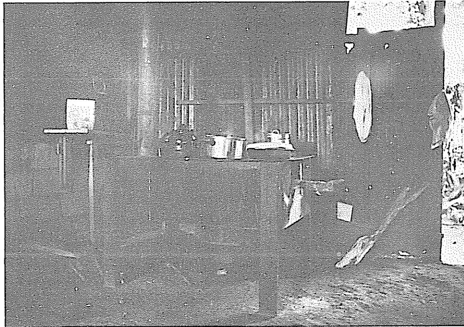
FOTO N° 6. El fogón es un tipo de cocina que se construye localmente con ladrillo y cemento. A veces está cubierto por una lámina de hierro. En este caso aparece con una chimenea.
