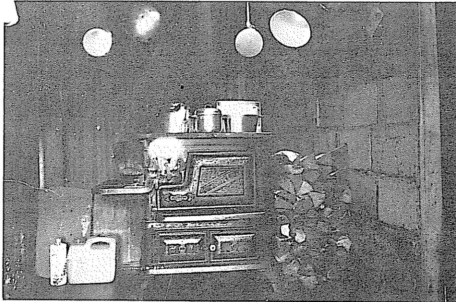
FOTO N° 9 Otro modelo de cocina de hierro. Obsérvese cómo la leña es apilada cerca de la cocina para facilitar su secado. Los recipientes a la izquierda contienen canfin que es usado para encender el fuego.
