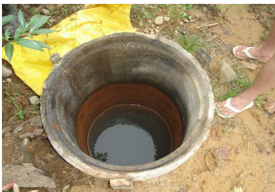
Foto 1. Pozo artesanal a presión atmosférica en la parte alta de la subcuenca
