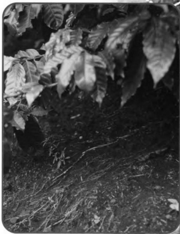
Raíces expuestas por erosión del suelo.
