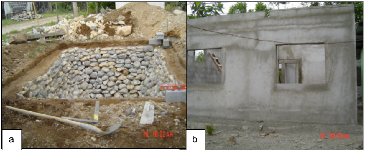
Figura 32. a) Construcción de tanque séptico; b) Ampliación de infraestructura. Ambas obras se ejecutan en el CESAMO de Santa Ana, municipio de San Francisco y por el proyecto PROMESA
