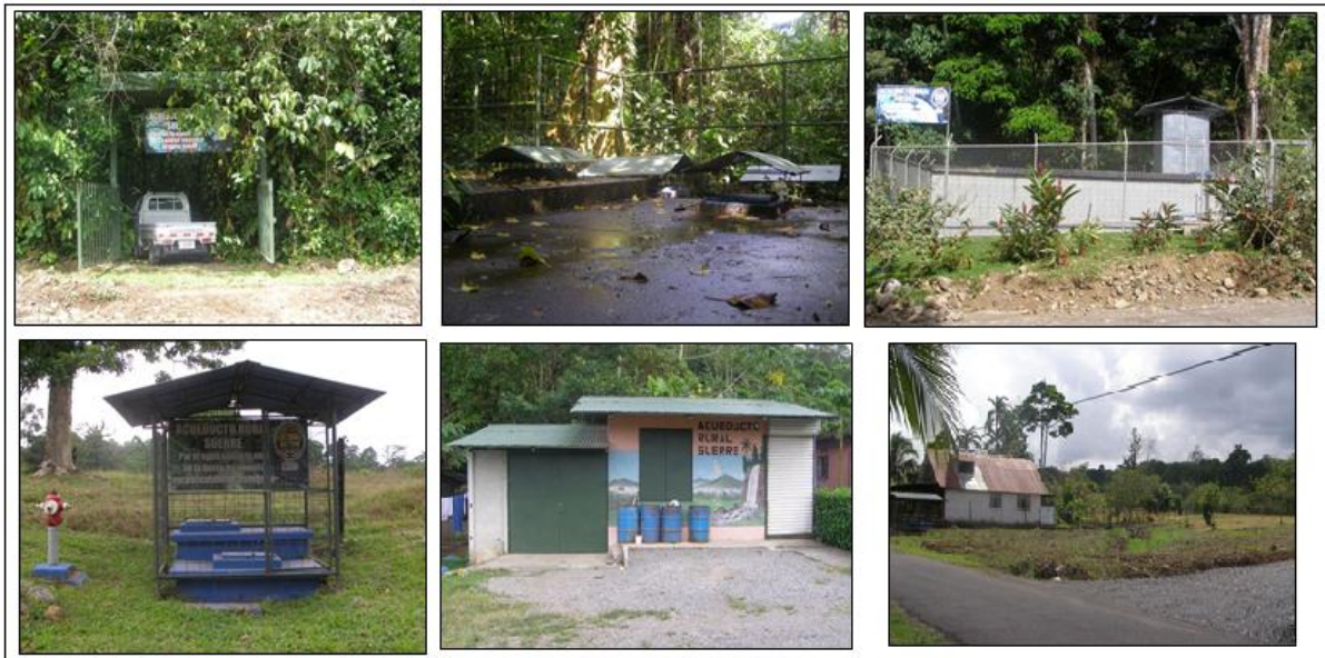
Figura 11. Bienes y acueducto de la ASADA de Suerre. De izquierda a derecha y de arriba hacia abajo: entrada al manantial y vehículo, obra de captación, tanque de almacenamiento, quiebra gradiente e hidrante, oficina, terreno para futura oficina y centro de capacitación.
