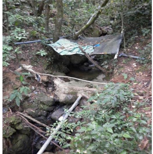
*Figura 27 (izquierda). Captación de la quebrada Cucaracha (ASADA Higuito), que aporta 40% del agua del acueducto.*
