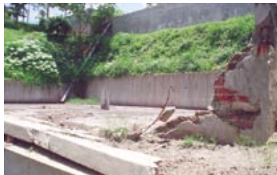
Pared en digestor.
