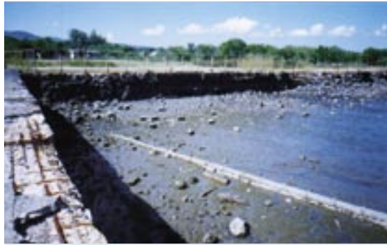
Descarga de aguas residuales crudas en La Unión, El Salvador, directamente al Golfo de Fonseca.
