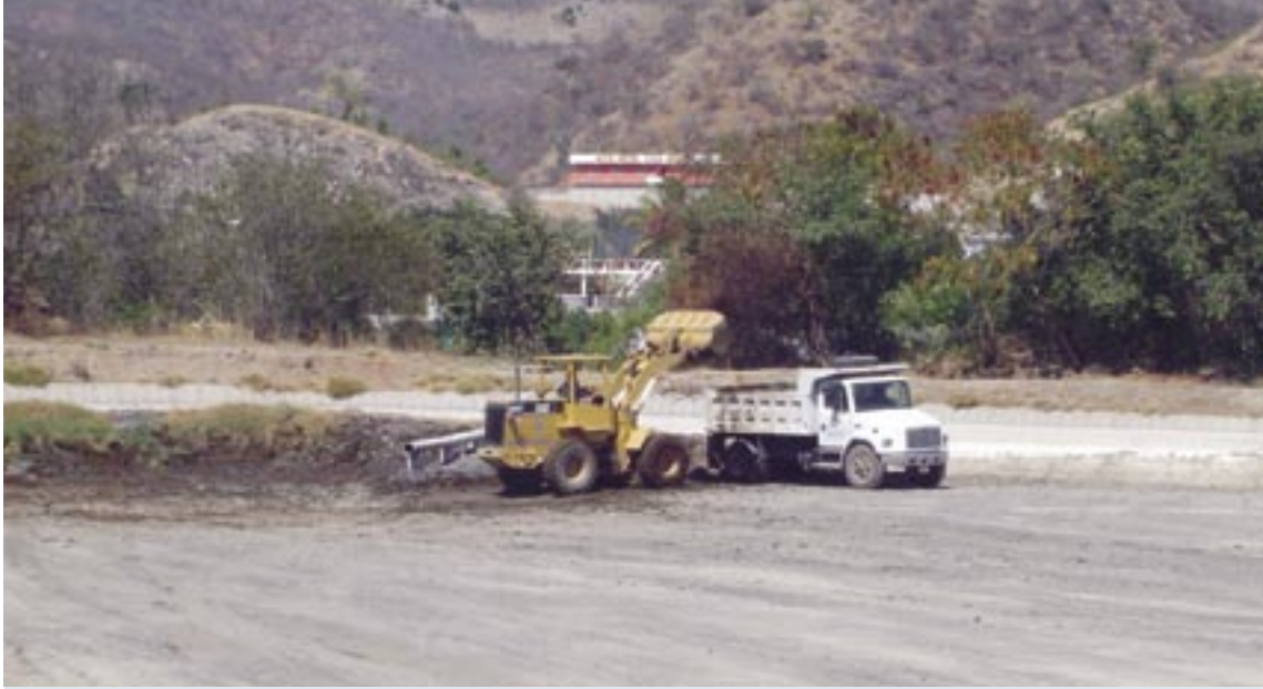
Extracción de lodos en Lagunas, Guastatoya, Guatemala.
