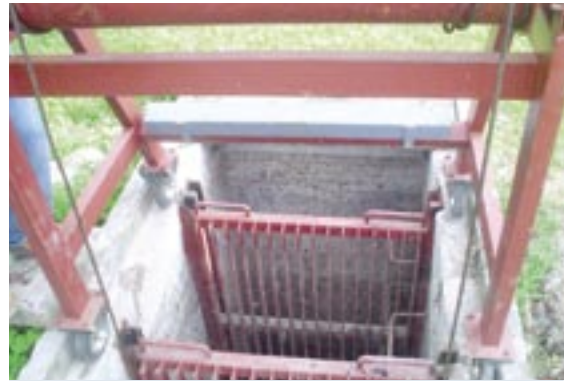
Reemplazo de rejillas en Nacaome, Honduras.
