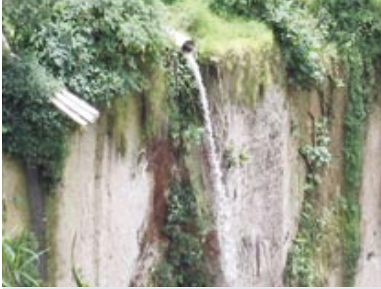
Tubo de descarga a planta.
