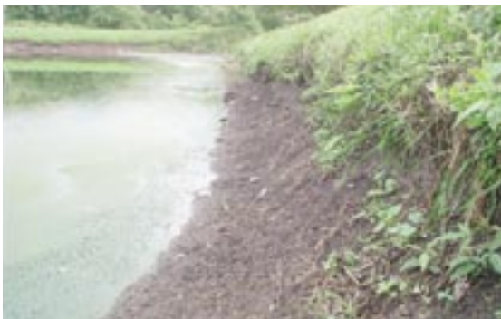
Taludes en lagunas.
