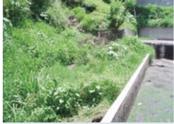
Patios de secado de lodos con vegetación.
