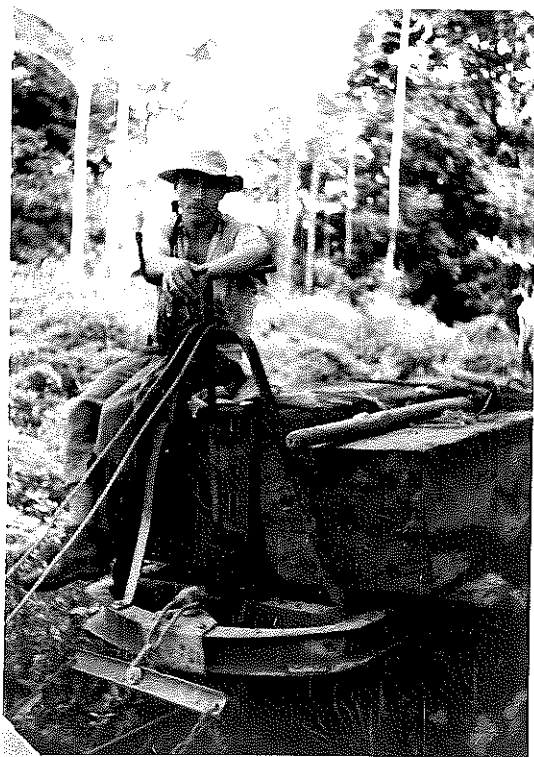
Fig. 41. Transporte de trozas en carros de tranvía.
