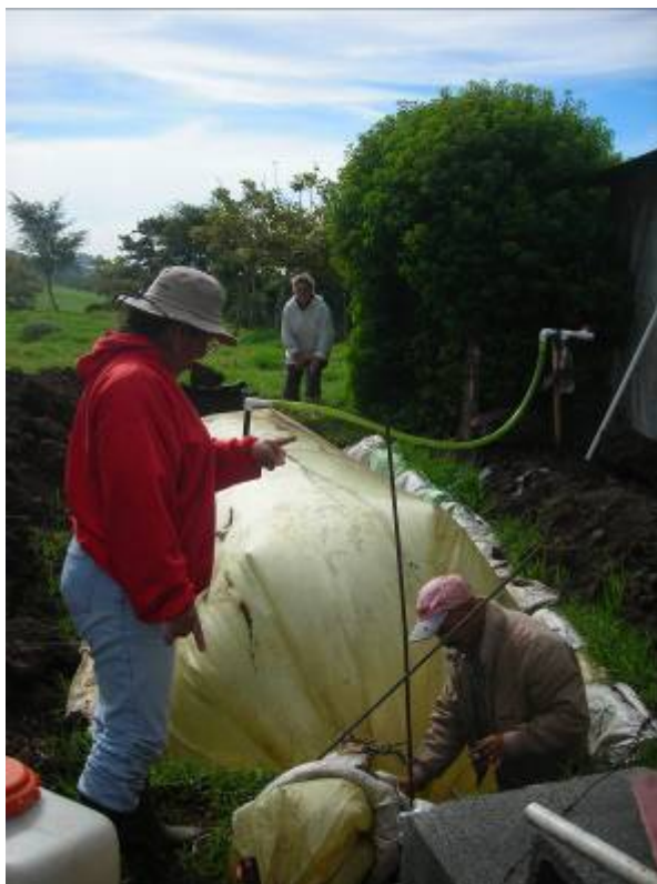
Foto 16: Instalación de un biodigestor en la cuenca del río Birrís.
