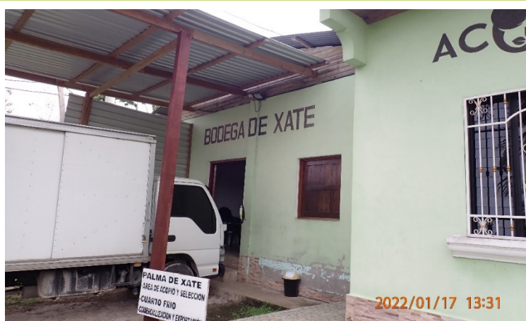
Figura 32: Camión para transporte de RFNM y bodega de xate dónde se encuentran los cuartos fríos.
