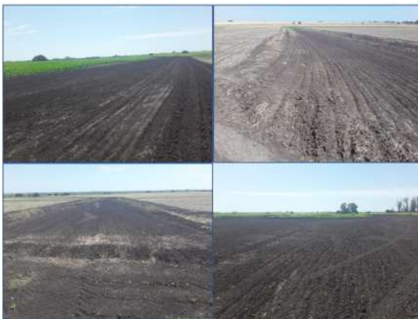
Figura 11: Inicio de construcción de canales evacuadores. Fuente: AELF-Berardo Agropecuaria.
