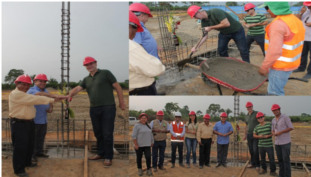
Figura 110. Fotografía del inicio de obra de la planta de beneficio en el año 2016
