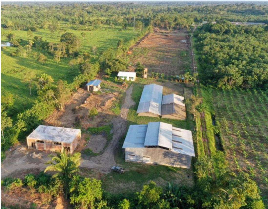
Figura 87. Vista aérea de la planta de beneficio al 2022, con las nuevas infraestructuras construidas entre los años 2020-2022 y el jardín clonal
