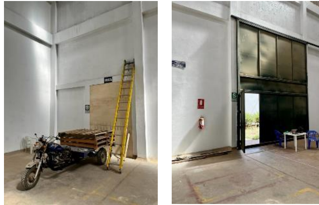
Figura 32: Moto de carga y puerta de planta. Fuente: Propia
