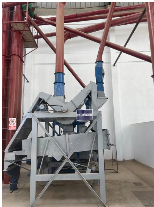
Figura 34: Poza de alimentación y prelimpiadora Fuente: Propia
