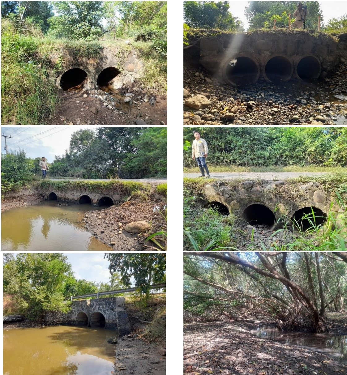
Figura 20. Fila superior y centro: alcantarillas que conectan al MBS con el estero de la bocana del río El Rosario. Foto inferior izquierda: alcantarillas que conectan al MBS con Garita Palmera. Foto inferior derecha: canal que conecta al Estero del río El Rosario con el estero Costa Azul bajo condiciones de avanzado azolvamiento.
