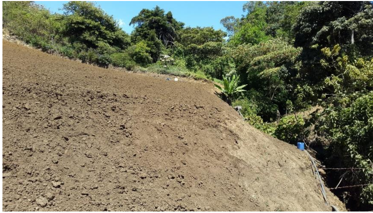
Figura 8. Suelo desnudo y mecanizado con problemas de erosión a favor de pendiente
