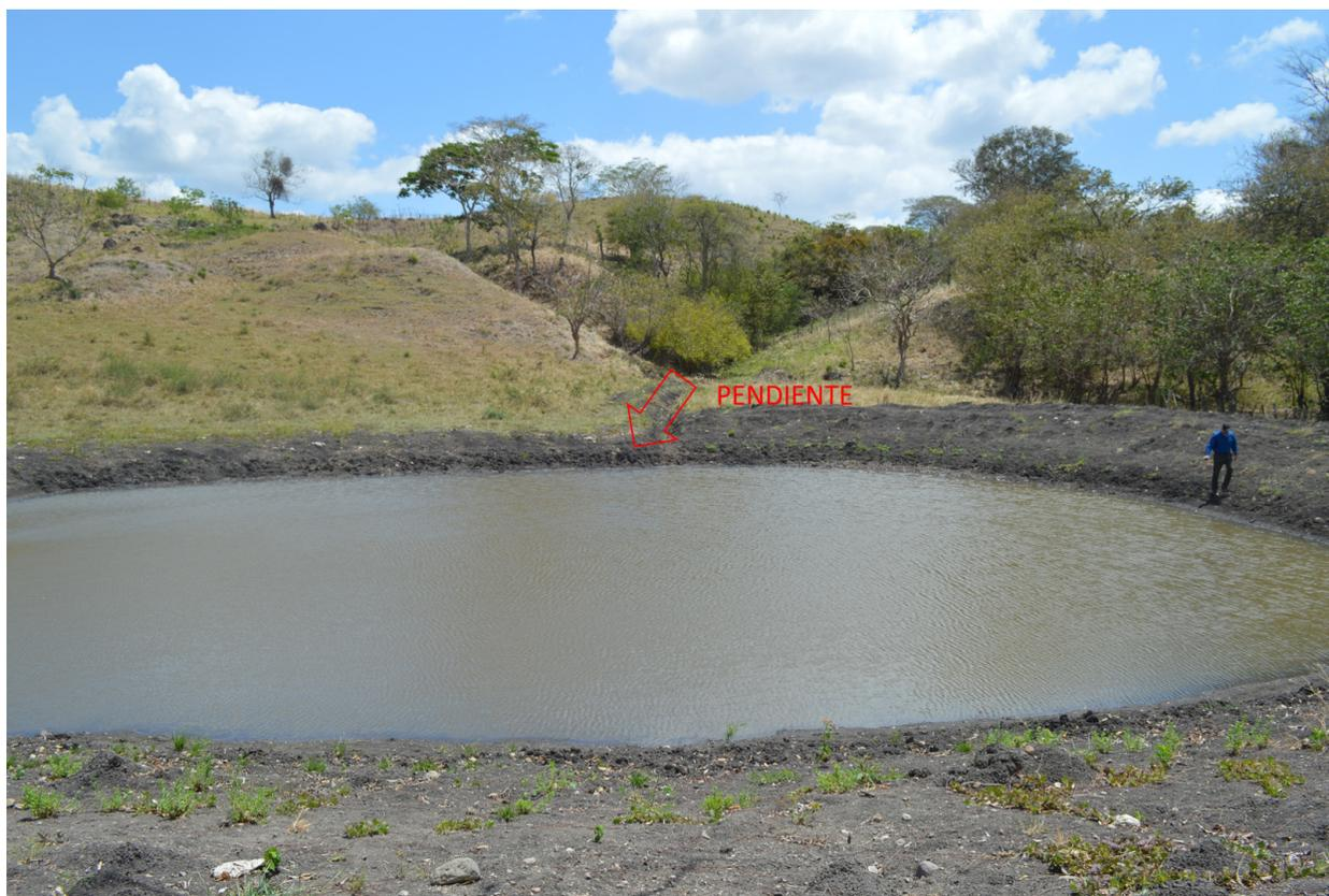
**Figura 20.** Verificación pendiente del terreno (%) para definir sitio de construcción de obra de cosecha de agua
