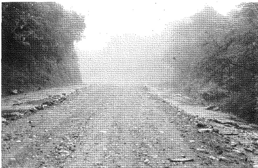
Fig. 14. Estado actual de la carretera principal (Regional N° 120). Es transitable todo el año para cualquier clase de vehículo, pero necesita mantenimiento regular para evitar el deterioro por los frecuentes chubascos de la región. Foto M. A. Boza.
