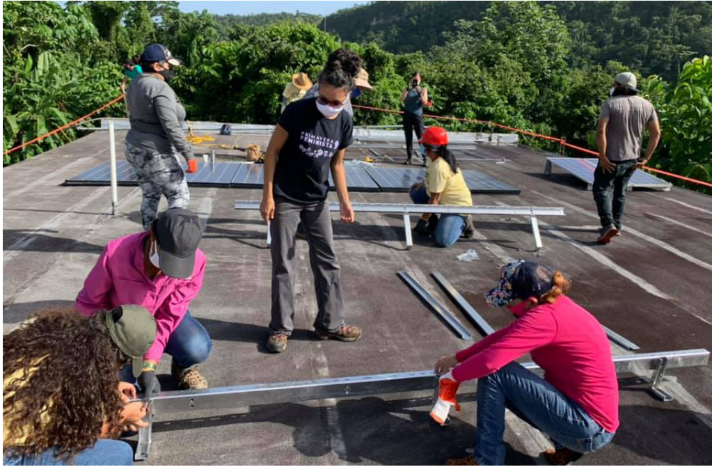
Figura 10. Capacitación en el armado de paneles solares en el Bosque Modelo Nacional, Puerto Rico
