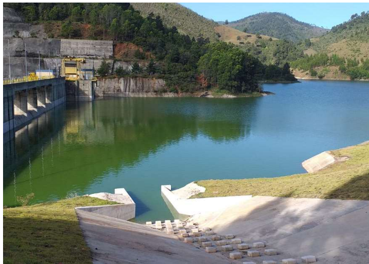
Figura 3. Embalse y casa de máquina de la Hidroeléctrica Pinalto, Constanza, La Vega, República Dominicana
