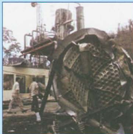
Incendio y explosión en tanque de alcohol, Punta Morales, Puntarenas, Enero 2002.
