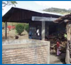
Pileta para captación de agua pluvial para fines domésticos
